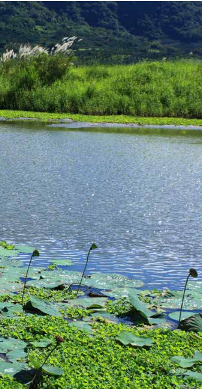
■ 玉水圳濕地的調節閘。
