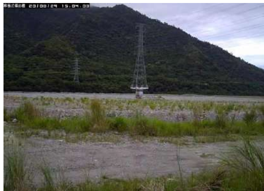
立霧溪CCTV監控情形
