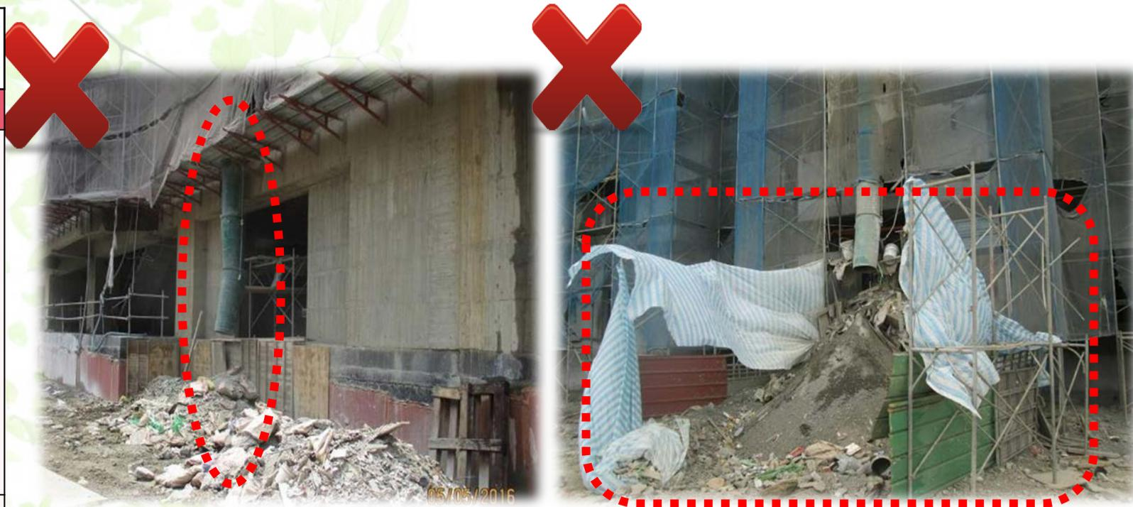
輸送管道出口，未設置可抑制粉塵逸散之圍籬並灑水設施，致產生揚塵。
