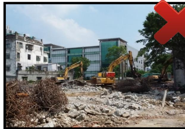
第一級營建工地未採行灑水及結構體包覆塵網(缺失記點10點)
