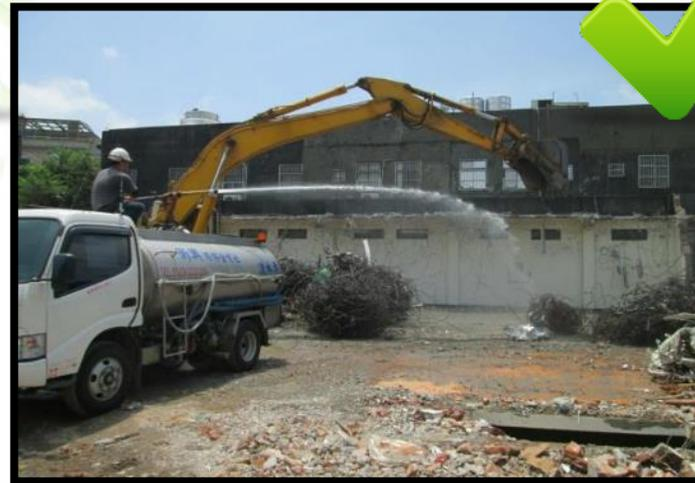
拆除作業進行時，配合加壓噴灑水
