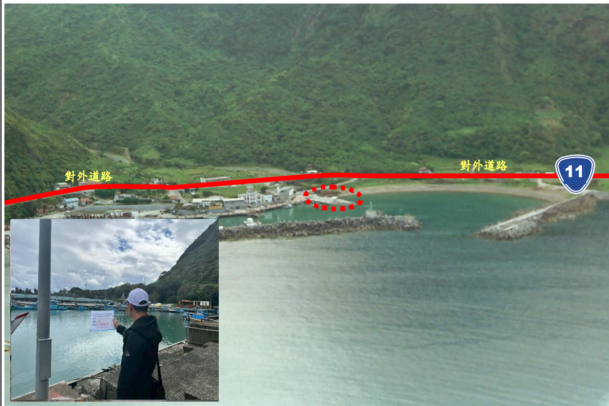
現場相片石梯漁港
