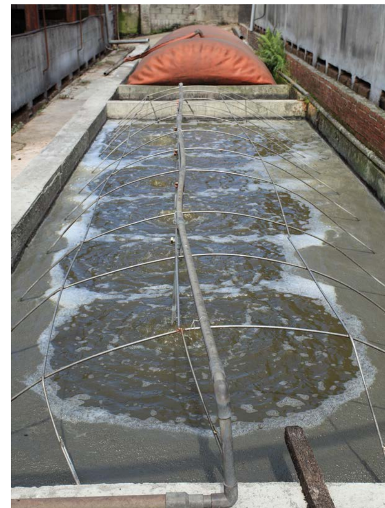
養豬戶廢水以往採三段式厭氧處理，圖為花蓮養豬戶的廢水處理設備。
