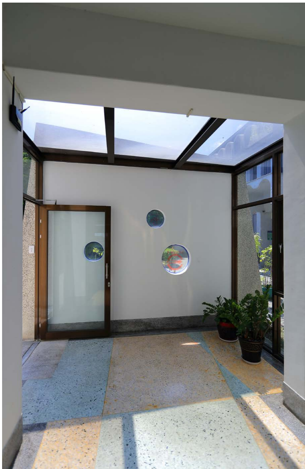
標檢局花蓮分局建築重視採光、通風，具有綠建築概念。
